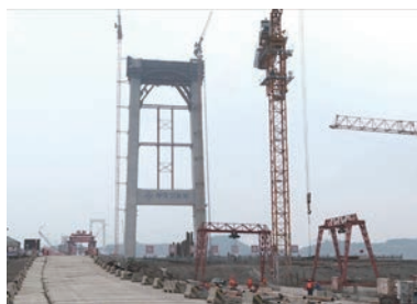
瓯江北口大桥项目复工现场
