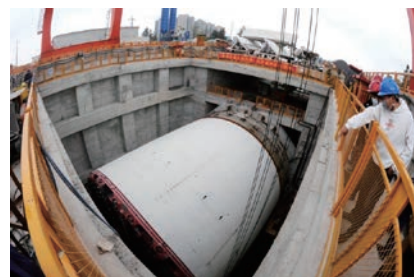
市域铁路S2线复工现场
