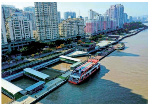
12月22日，经过提升改造后的江心屿景区麻行码头投入试运行，改造提升后，大大改善了码头软硬件设施，为江心屿景区整体开发打下坚实的基础
