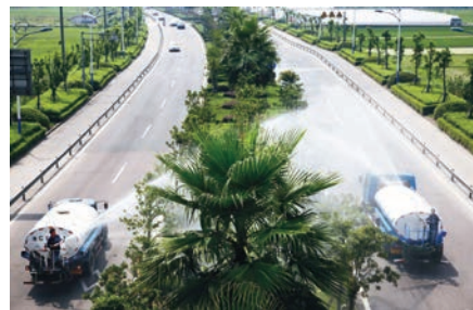
温瞿公路绿化改造提升
