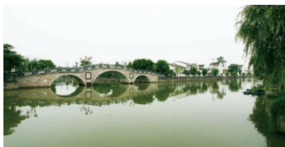
龙湾区瑶溪街道朱宅村整治后面貌
